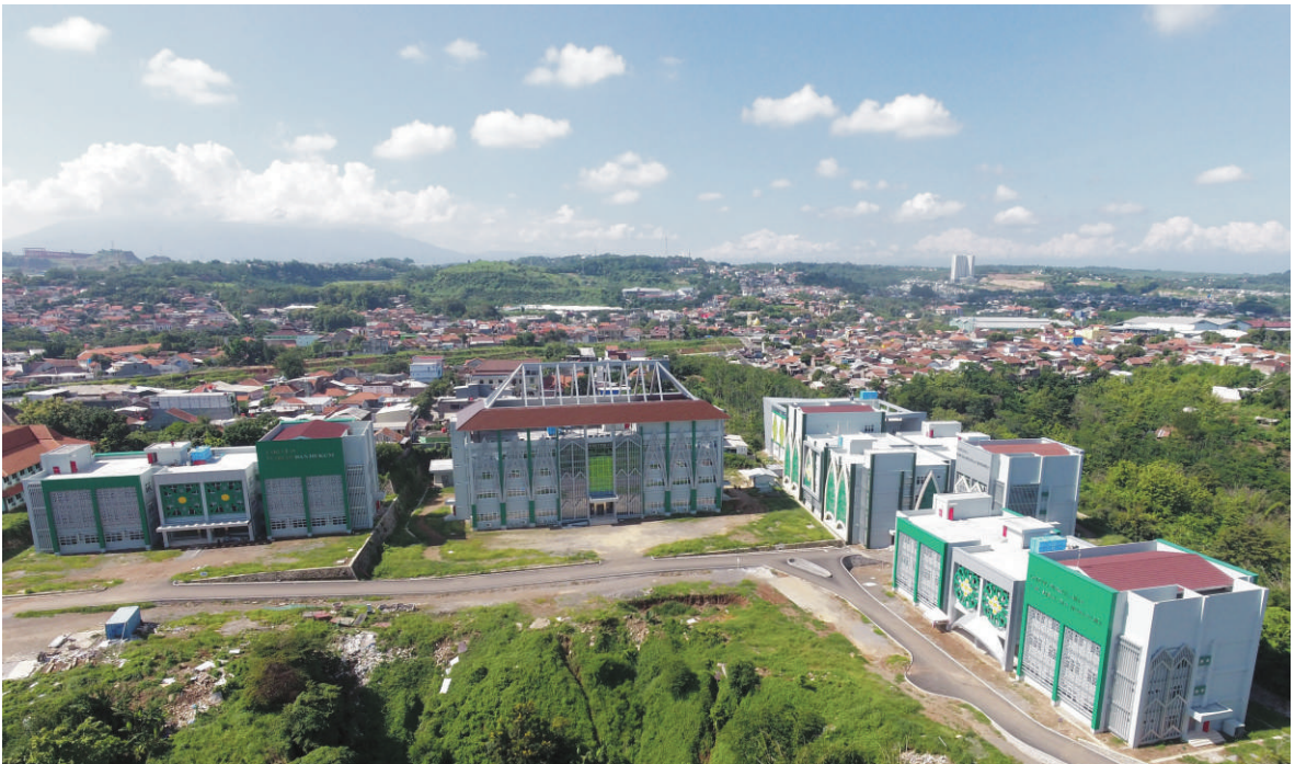
(Dokumentasi Kondisi Gendung IDB)
